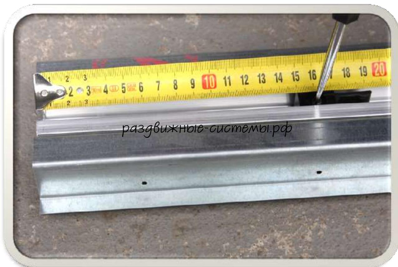
Из набора фурнитуры закрепить фиксатор двери на расстоянии 15 см. от края направляющей
