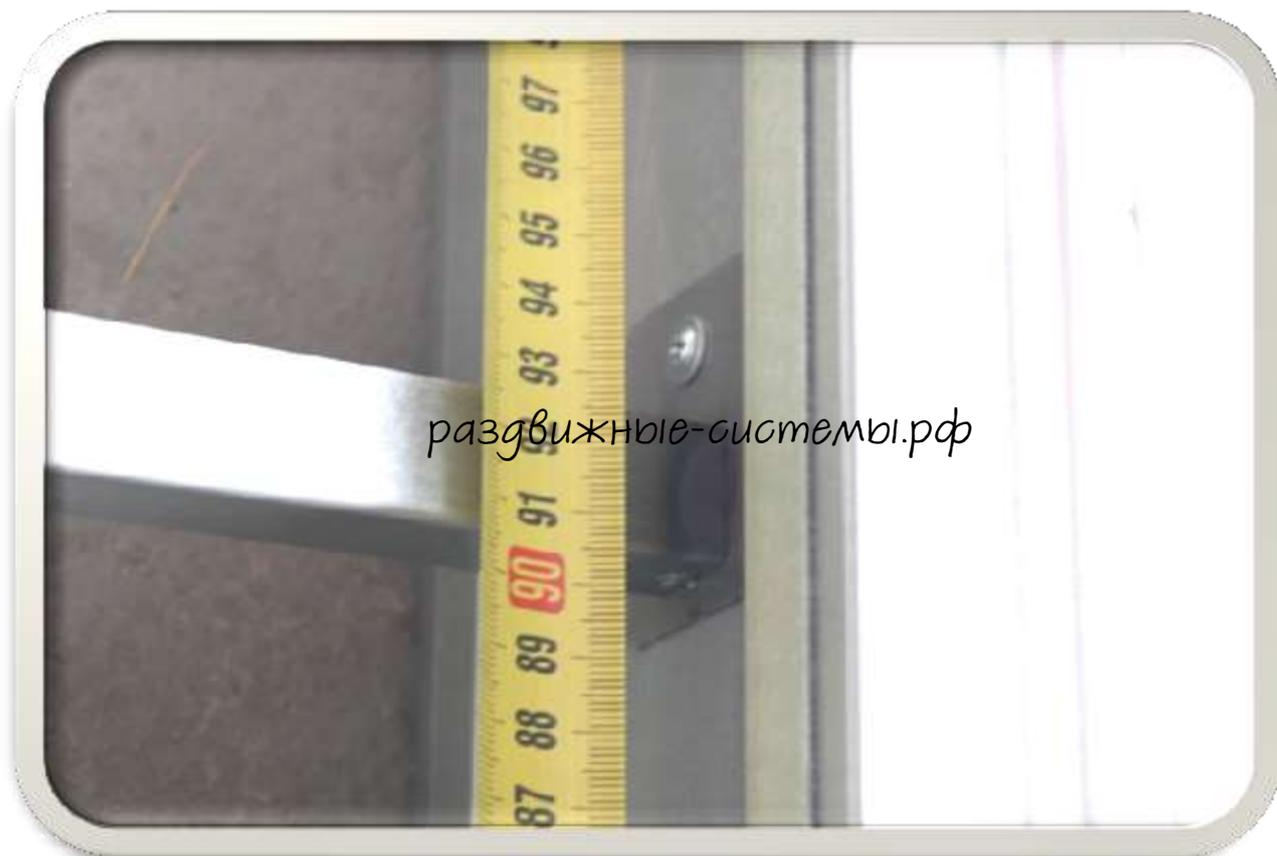
Зафиксировать по месту установочную распорку со стороны транспортировочного профиля
