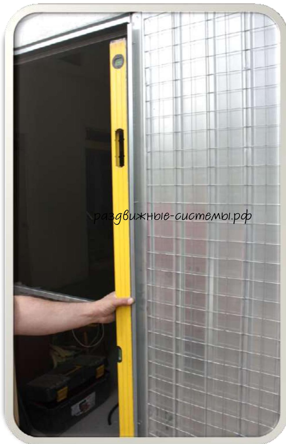
Отбалансируйте пенал в горизонтальной и вертикальной плоскостях с помощью уровня.
