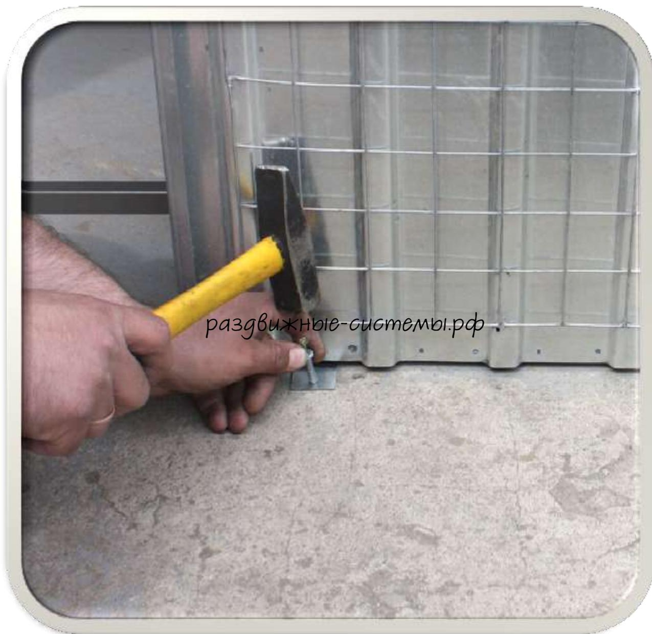
Отогните фиксатор с двух сторон и закрепите пенал к полу с помощью дюбель гвоздей.
