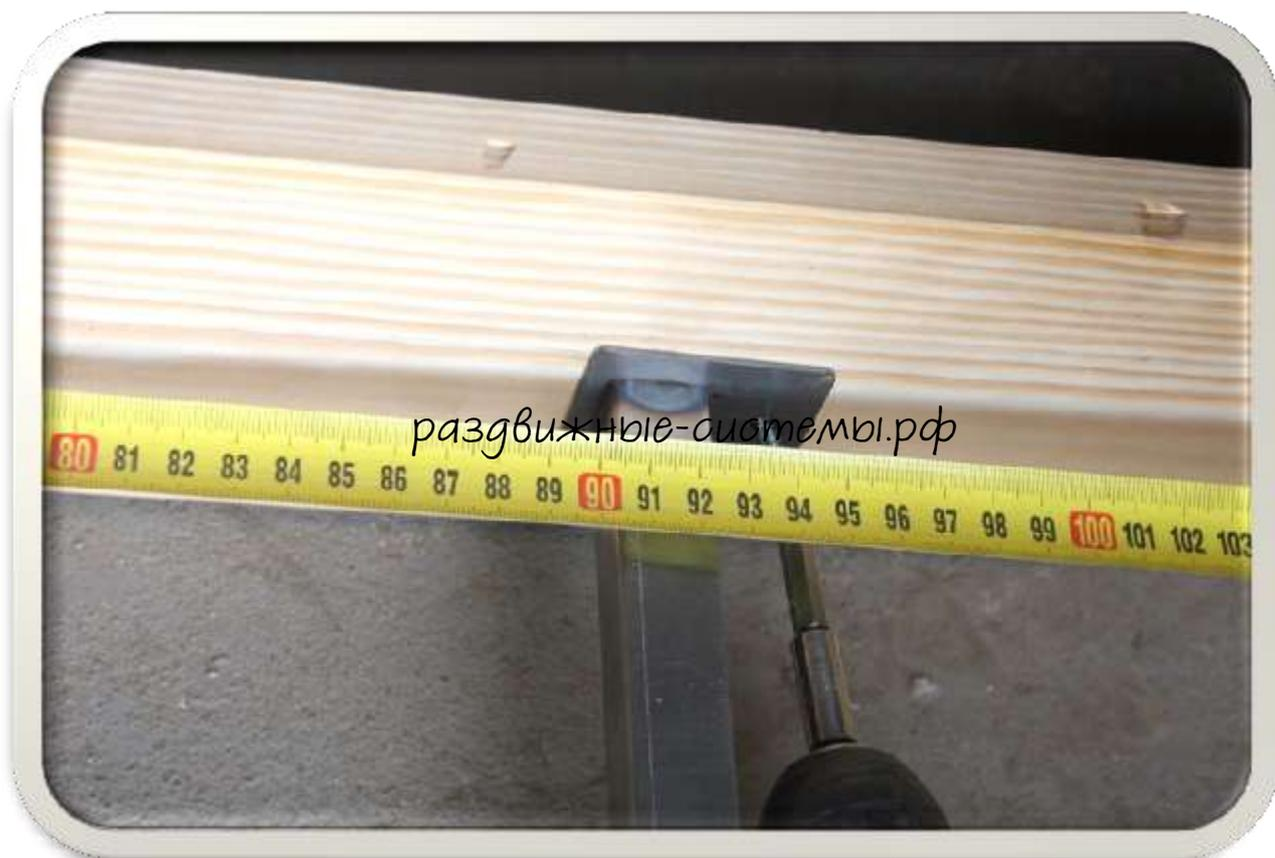
Разметить и зафиксировать установочную распорку со стороны деревянной подставки
