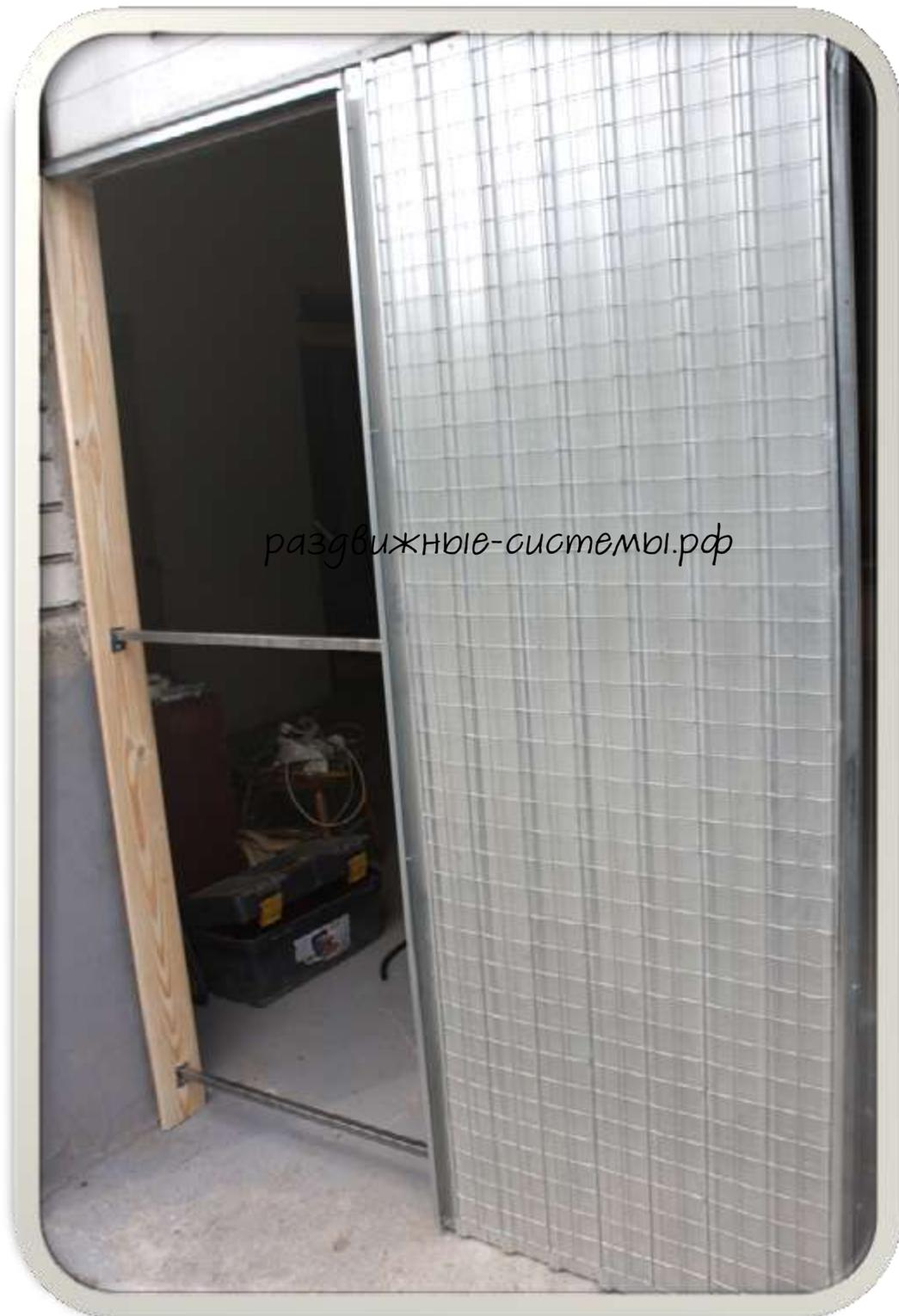
**ВАЖНО!!!** Установите пенал в проём стены на высоте планируемого чистового пола.
